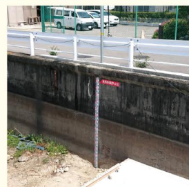
下の池 令和2年池4月23日設置 (自主防災会の経費で設置)
