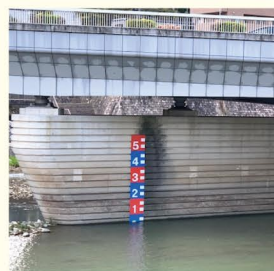
宝来橋 令和2年2月中旬設置 (自主防災会の要望により県の経費で設置)
